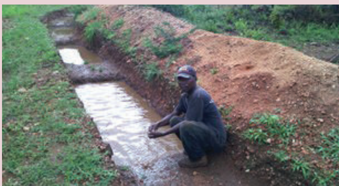
Barrage en terre de récupération de l'eau creusé dans les terres arables Photo par: Nelson Mudzingwa
